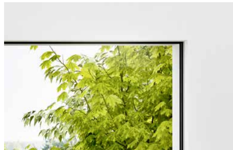
Der Rahmen verschwindet fast zur Gänze in der Fassade.
