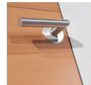
Türblatt und Wand in einer Ebene
